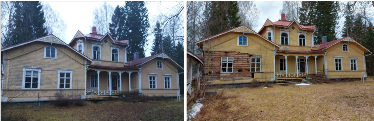
Åströmin huvilan päärakennus joulukuussa 2020 ja toukokuussa 2023.
